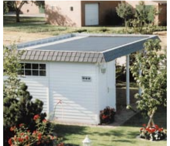
Eine Gartenlaube von 22 qm Fläche ist hier Grundlage für die MITRA Solarabsorber.
