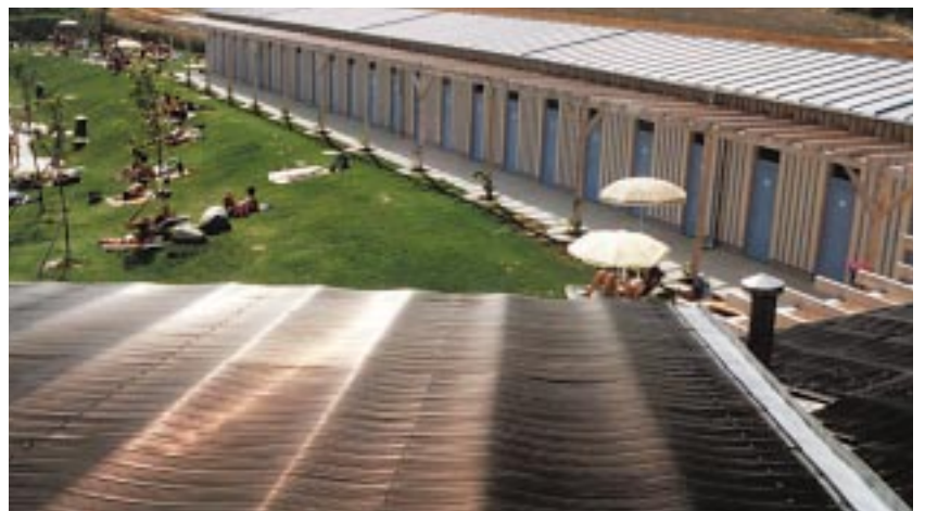
Durch die Stecksammelrohre der MITRA Solarabsorber wirkt die Kollektorfläche sehr kompakt. Dank einem Breitenraster von 25 cm und einem Längsraster von 10 cm können alle Dachflächen optimal belegt werden - ohne Anschlusszwischenräume.
