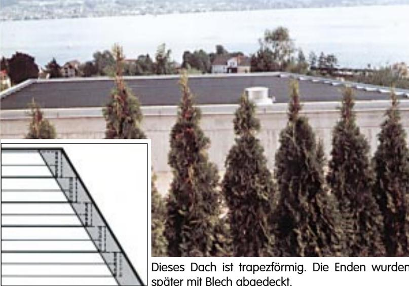
Dieses Dach ist trapezförmig. Die Enden wurden später mit Blech abgedeckt.
