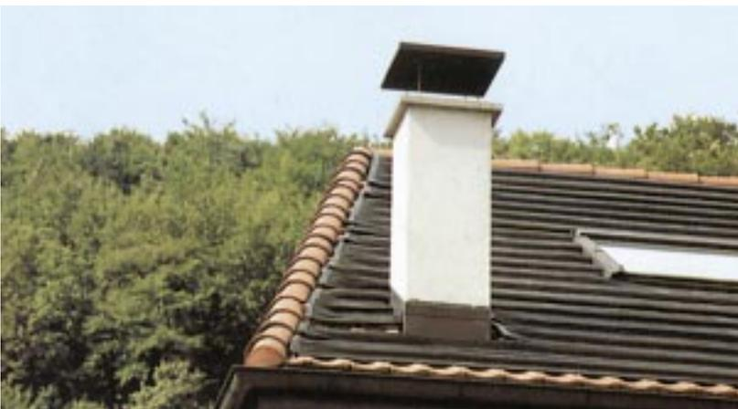
Diese Dachfläche wurde zu 100 % mit MITRA Solarabsorbern bedeckt. Kleine, unrentable Flächen wurden aus ästhetischen Gründen mit Blindstücken ausgelegt, z. B. hinter dem Kamin.
