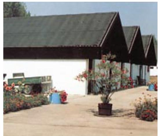
Eine optimale Anusnutzung der Dachfläche zeichnet auch diese Anlage mit MITRA Solarabsorbern aus. Dabei werden mehrere Dachflächen in Reihe geschaltet und in den Solarkreislauf eingebunden.
